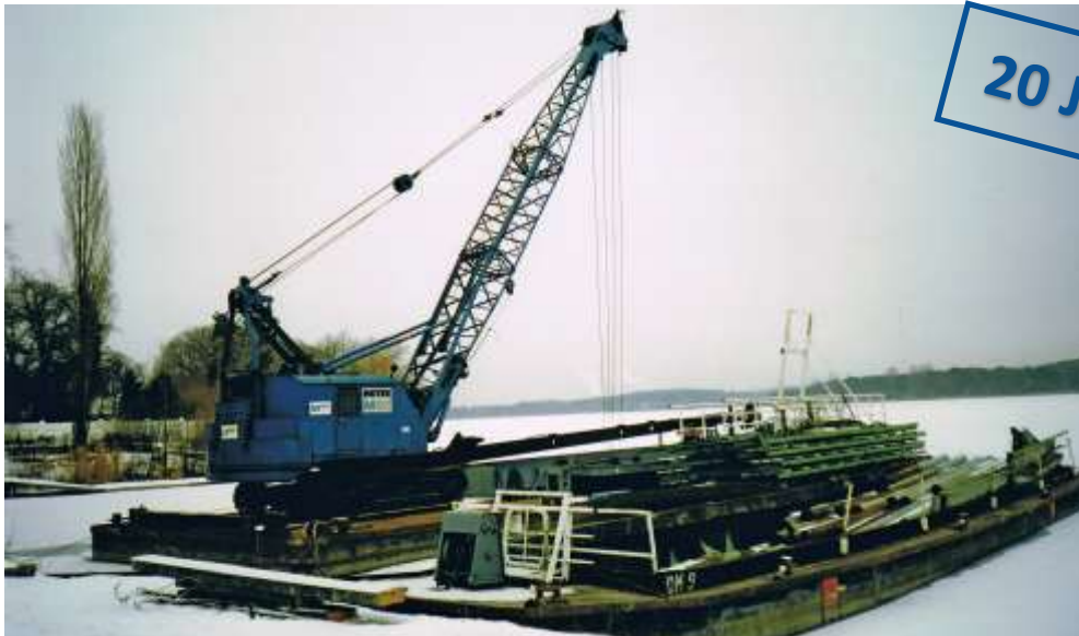
Umbau der Steganlage
