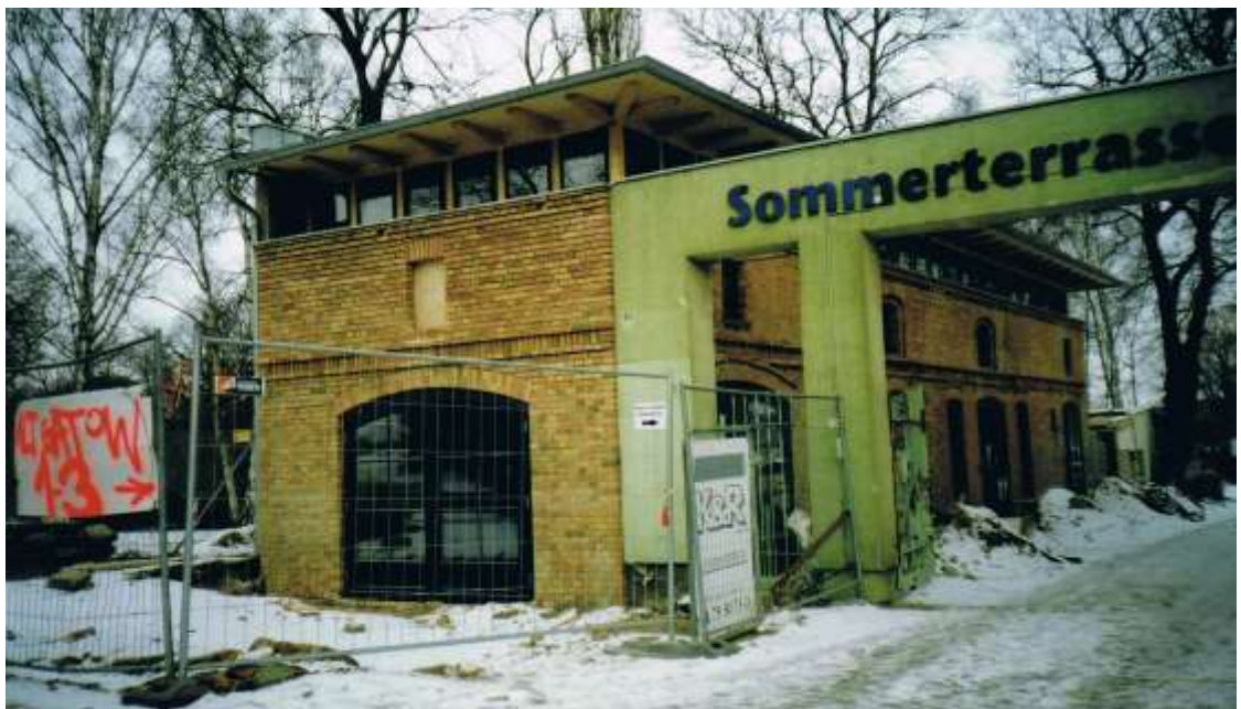
Der Umbau geht voran
